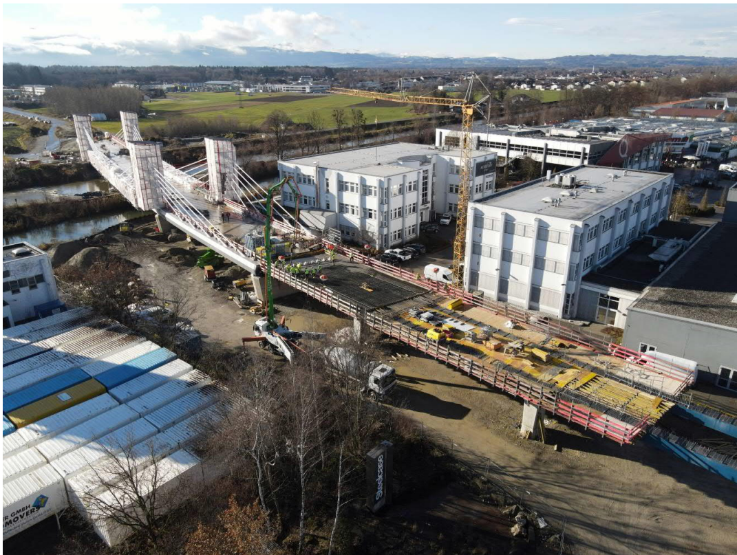
Links: Teilbauwerk 1 – Mangfallbrücke, Rechts: Teilbauwerk 2 – Aicherparkbrücke Blick Richtung Süd-Westen: Betonage Betonierabschnitt 16 Foto: HABAU
