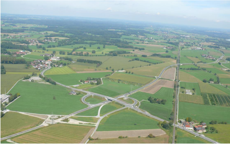
Bauabschnitt 4: Blick von Südosten auf die Anschlussstelle St 2080 und den weiteren BA 4 (Foto: Schellmoser)
