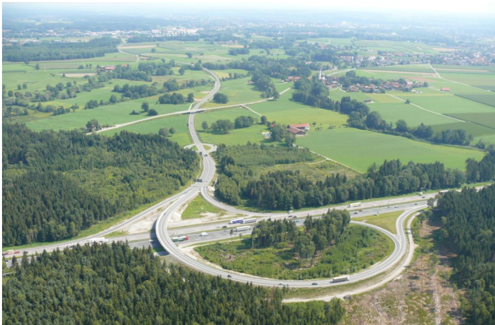
Bauabschnitt 1: Blick von der Anschlussstelle Rosenheim West in Richtung Norden über den BA 1 (Foto: Schellmoser)
