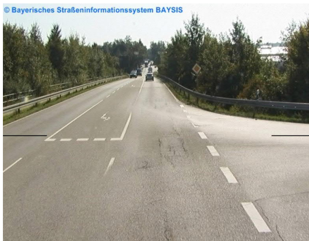
Abbildung 1: St 2080 Beginn der Baustrecke (Abschnitt 220, Station 0,120; IN-Station)
