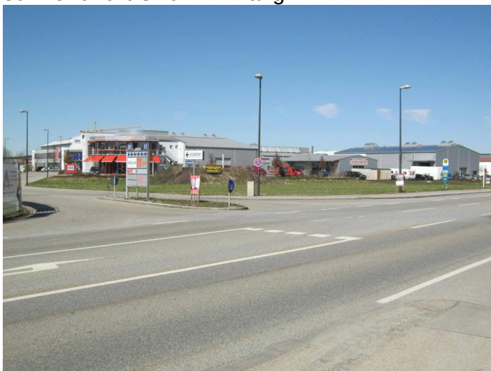
Abbildung 11: Einmündung Römerstraße in St 2080 (Ortsteil Moos)
