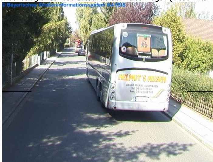
Abbildung 6: St 2080 Ortsende Schwaberwegen Rückbild (Abschnitt 240, Stat. 0,380)
