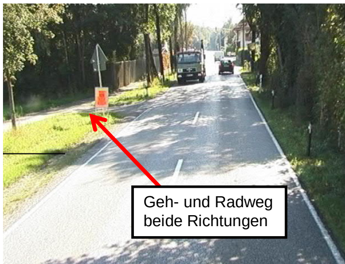
Abbildung 4: St 2080 Ortseingang Schwaberwegen (Abschnitt 220, Stat. 1,200)
